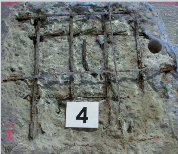
Nach der Potentialfeldmessungen werden bei den unterschiedlichen potentialen Sondieröffnungen zur Eichung der Potentialfeldmessung erstellt. An den Öffnungen wird der Korrosionsgrad der Bewehrung gemessen und Proben für die Chloridgehaltsbestimmungen entnommen.
